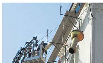
PFARRKIRCHE FRIEDBERG Erneuerung Turmdeckung
