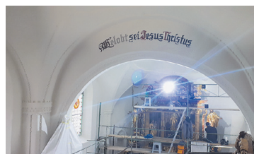
PFARRKIRCHE NOREIA Innenrenovierung
