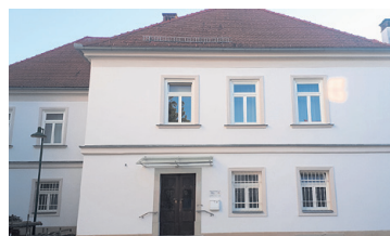
PFARRHOF KNITTELFELD Renovierung Fassade
