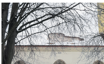
PFARRKIRCHE ROTTENMANN Dach 2. Abschnitt
