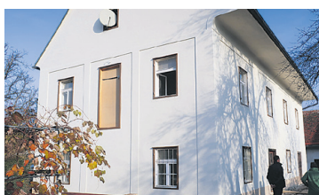
PFARRHOF LANG Renovierung und Umbau Wohnung OG
