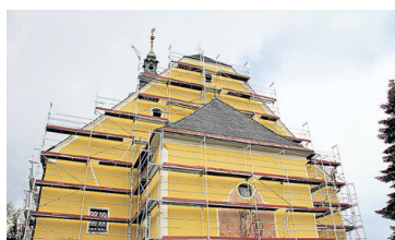
PFARRKIRCHE WIES Außenrenovierung
