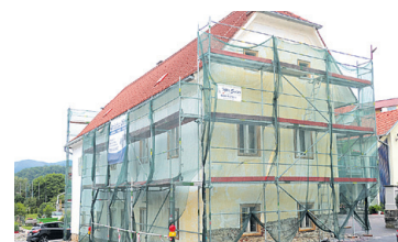
PFARRHOF GRATKORN Renovierung Fassade und Fenster
